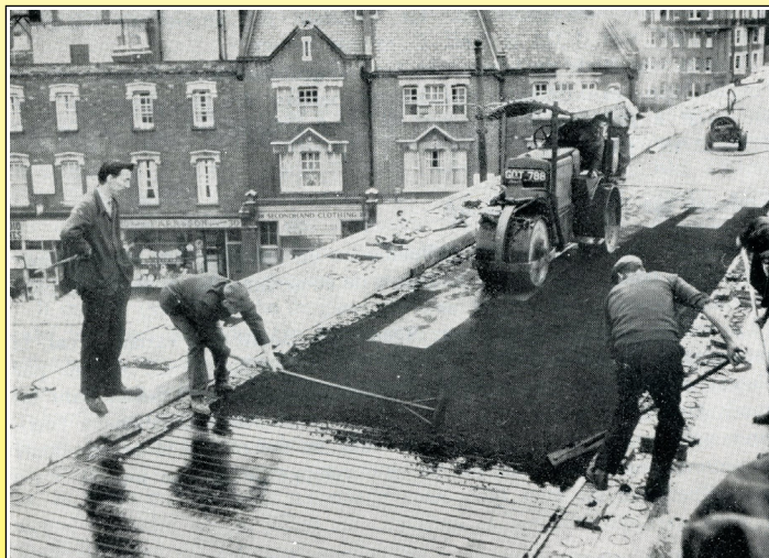
1969 Pose du revêtement sur la chaussée supérieure d'un carrefour de Hammerschmidt à Londres (Chauffage électrique des chaussées, par Robert Félix, 1971, Musée Ultimheat* )
